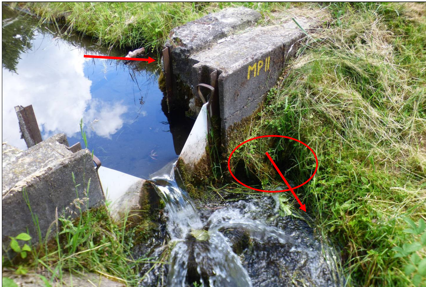
VD Slušovice - rekonstrukce - SO - 06 Měřicí zařízení TBD rekonstrukce obou měrných přepadů v odvodňovacím příkopu (MP I., MP II.). Měrný přepad MP II. v konci odvodňovacího příkopu – obtékání přepadu (06.06.2023).
